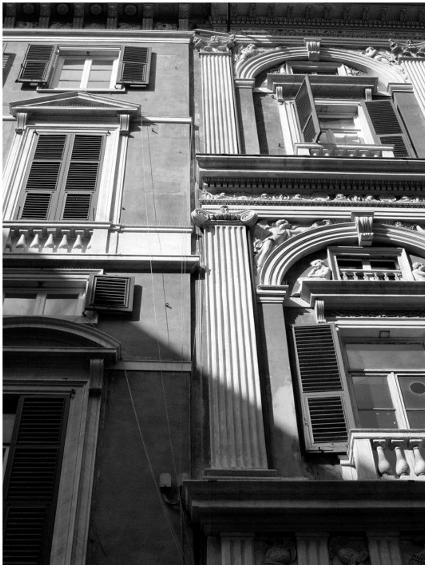
Fig. 13 - Palazzi Sauli e Solari, poi palazzo della Banca Nazionale di Sconto, prospetto verso via San Lorenzo, particolare dell'attacco tra le due costruzioni originarie.
