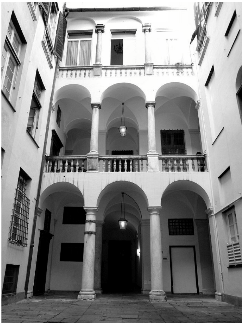
Fig. 8 - Cortile. Prospetto sul lato nord. Al piano terra, sullo sfondo, quello che resta dell'atrio che originariamente occupava lo spazio delle due campate di sinistra in chiara asimmetria con il cortile.
