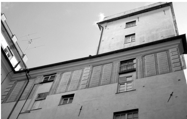
Fig. 10 - Genova, Palazzo di Antonio Sauli; la torre e parte della facciata dell'ala sud' del palazzo con tracce dell'antica decorazione bicroma.
