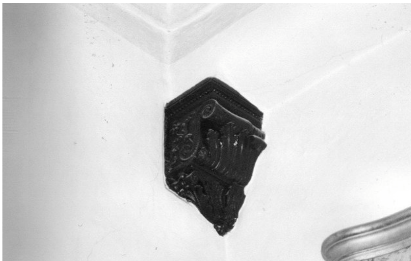
Fig. 5 - Genova, Palazzo di Antonio Sauli; una delle mensole della copertura lignea dell'originaria caminata .
