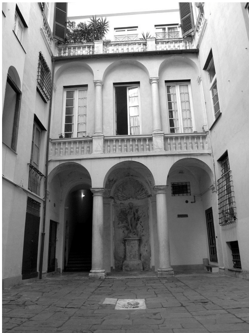
Fig. 7 - Cortile. Prospetto sul lato sud. Per chi entra nel cortile il fuoco prospettico converge verso la statua. Oltre il loggiato, il varco aperto per realizzare i due corpi scala di accesso alle case che in origine avevano l'entrata su via di Mascherona.
